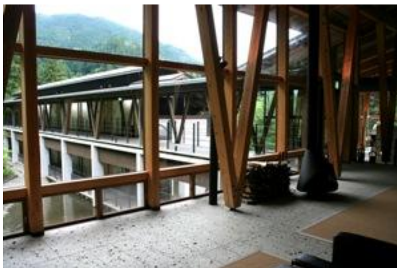
写真7 オーベルジュ土佐山のエントランス
