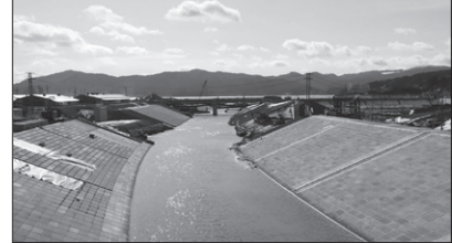
8-(6) 八幡川河口(河川堤防と防災対策庁舎)
